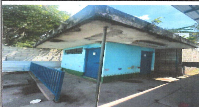
FOTO2: PINTURA EN MUROS INTERIOR Y EXTERIOR
