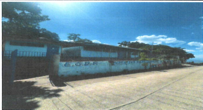
FOTO1: PINTURA EN MUROS INTERIOR Y EXTERIOR
