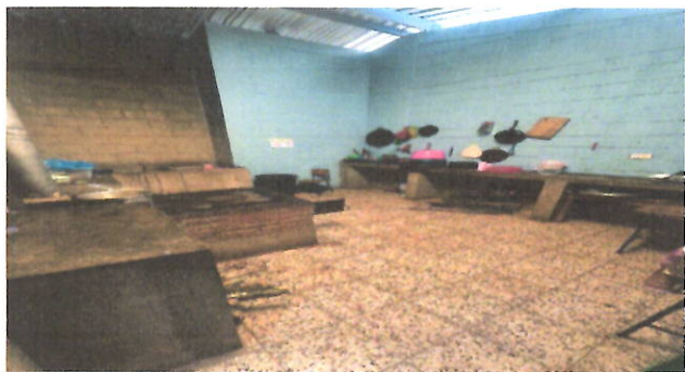
FOTO5: REPARACIÓN O SUSTITUCIÓN DE AZULEJO
