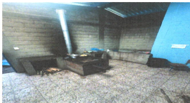
FOTO4: REPARACIÓN O SUSTITUCIÓN DE ÁREA DE COCINA
